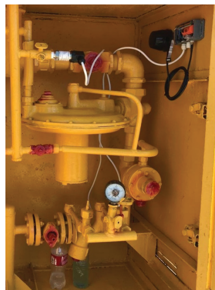
Рис. 6. Построение табличного и графического отчета по измеренному давлению на газораспределительном пункте за заданный период времени: логгер PROMODEM опрашивает датчик давления на объекте каждые 2 часа (можно и раз в минуту) и отправляет архив измерений на сервер раз в сутки (можно каждые 15 минут)
